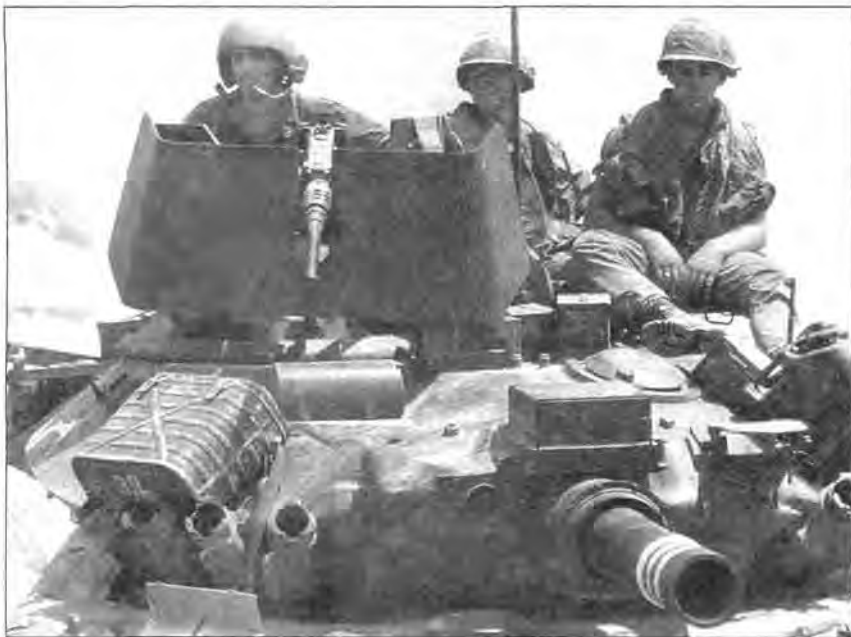
Sheridan во Вьетнаме крупным планом (слева). Над стволом орудия — кожух электронного устройства слежения за ИК-трассером ПТУР. Легкий танк M551A1 (внизу)
