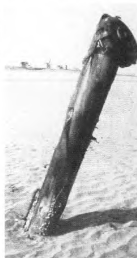
Надолб с установленной на нем миной
