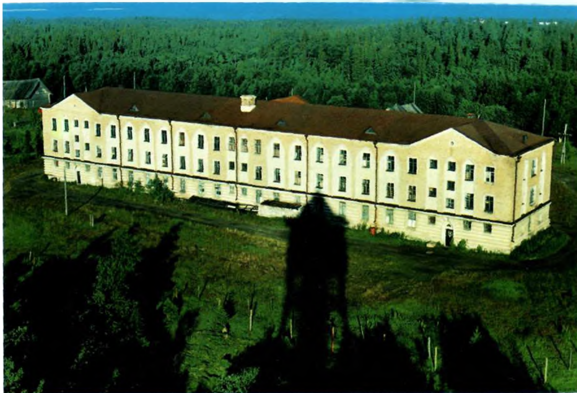
Большой тюремный корпус. 1939 год. Единственное капитальное сооружение НКВД на Соловках
