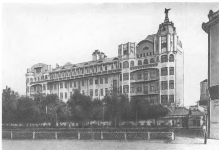
Москва. Тверской бульвар у Никитских ворот (дом Коробковой, сильно поврежденный во время боев 1917 г.) Из собрания В. А. Дрибинского
