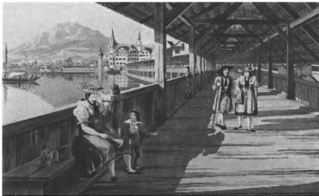
Мост в Люцерне
