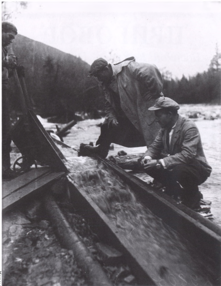
Промывка породы в старательной бригаде прииска «Евдокиевский» (Бурятско-Монгольской АССР, сентябрь 1938года).
