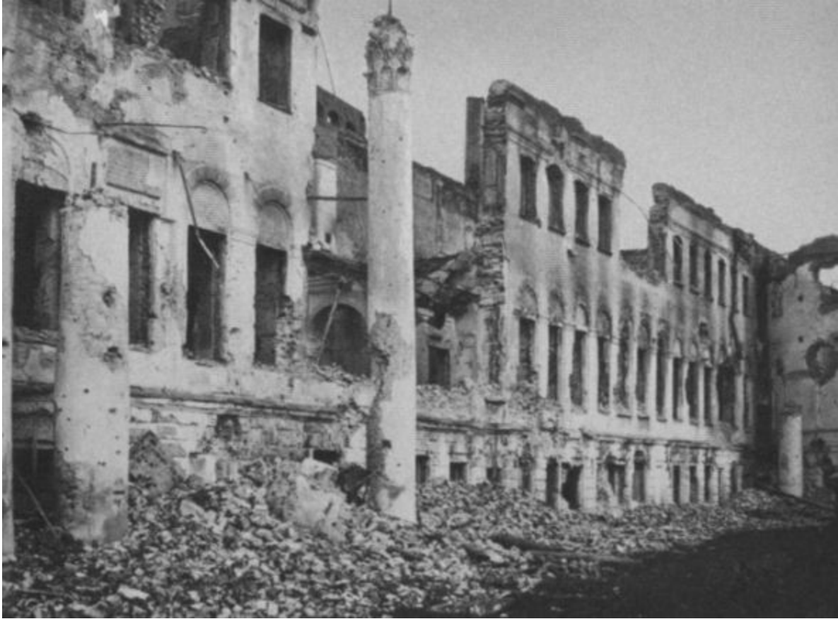
Здание Демидовского юридического лицея, разрушенное артобстрелом. Ярославль. 1918 г.
